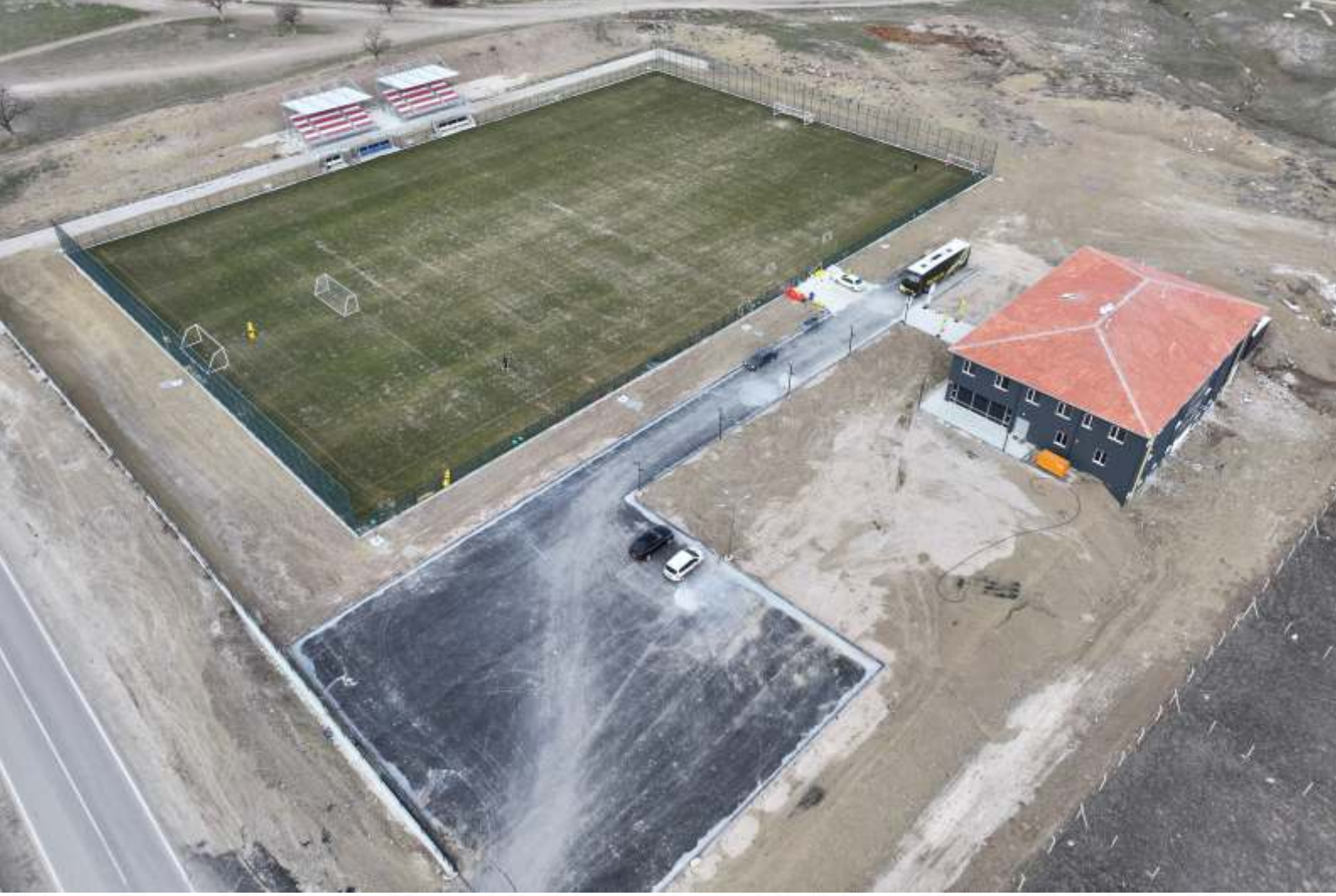
Mehmet Akif Mahallesi Spor Tesis ve Karapınar Mahallesi Spor Tesisinin İkmal (tamamlama) İnşaatı
